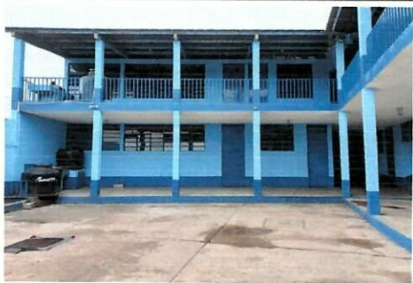
Foto 3: Instalación de cubierta metálica 235 mt²
