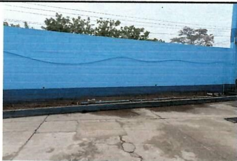
Foto 5: Instalación de cubierta metálica 235 mt²
