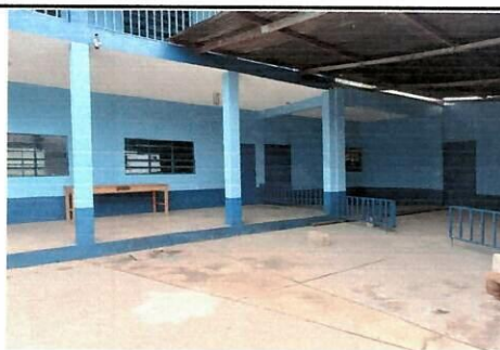
Foto 4: Foto 2: Cambio de iluminación 52 unidades
